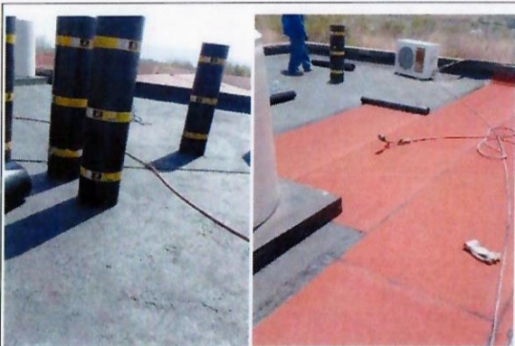
F37: Colocación de impermeabilizante prefabricado en el edificio 1
