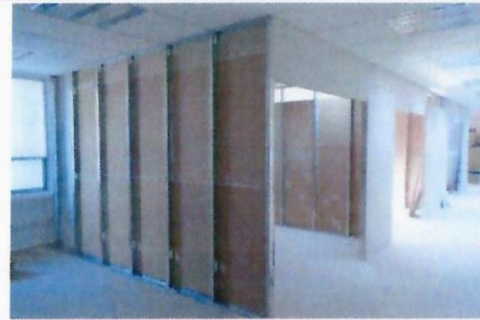
F7: Colocación de placas de muro divisorio.
