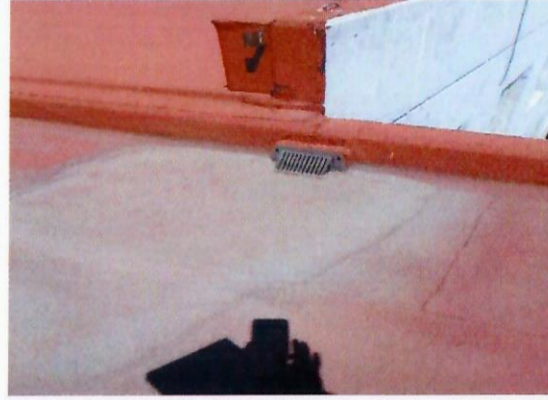
F7: Carpa dañada, retiro, suministro y colocación de impermeabilizante.
