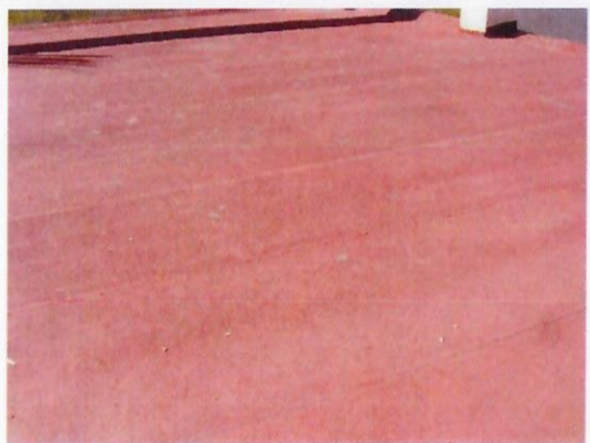
F3: Impermeabilización en losas de concreto
