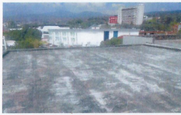
F9: Vista general de la losa de azotea en cubo de escalera y edificio 65 con trabajos de retiro de impermeabilizante deteriorado.
