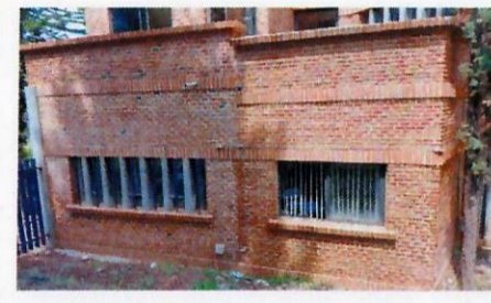
F46: Fachadas ya con impermeabilizantes SIPAQUARE
