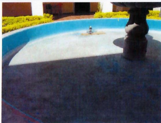
F6: Rehabilitación de fuente ornamental (Sellado, lavado , mto electrónico y aplicación de color)
