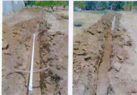
F10: Excavación de sepas y colocación de tubos de pvc para sistema de riego
