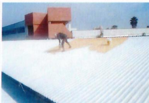
F14: Imagen de aplicación de poliurea color blanco sobre espuma de poliuretano, como acabado final. TAMULBA
