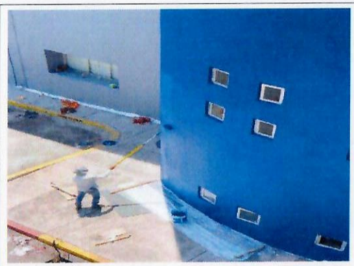
F26: Proceso de resane de grietas y aplicación de pintura. En exteriores
