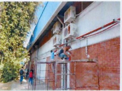
F32: Vista de los trabajos de aplicación de pintura de esmalte en tuberías exteriores de instalaciones en diámetros varios. (LOU)
