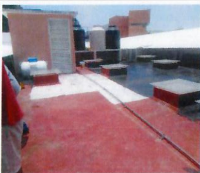
F16: Retiro de impermeabilizante deteriorado existente en cubierta de losa de acceso oeste a TAMULBA.
