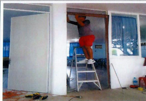
F28: Armado y colocación de Multipuerta
