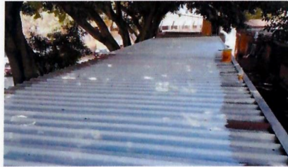
F10: Aplicación de impermeabilizante en cubierta metálica
