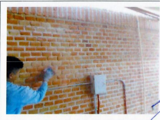
F-5: Retiro, suministro y aplicación de impermeabilizante
