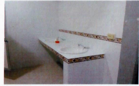
F12: Sanitarios: suministro y colocación de piso, azulejo, obalines con llaves economizadoras (Baño de hombres)
