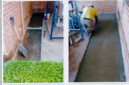
F18: Interior de aula (laboratorio) quitar adobe, para colocar concreto acabado pulido y ragado (foto izquierda). Anabado al concreto ya terminado (foto derecha)
