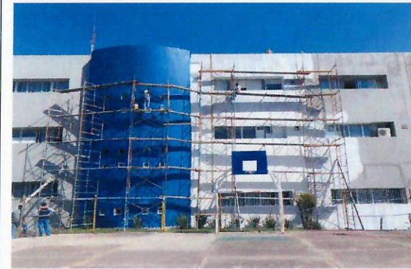
F18: Impermeabilización en muros a base de dos capas de Impermeabilizante acrílico 7 años y una capa de membrana poliéster marca sika edificio 6
