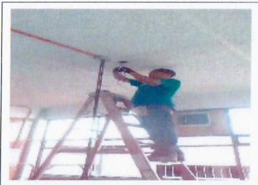
F14: Proceso de cambio de luminarias.
