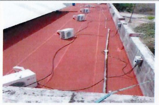
F45: Proceso terminado de colocación de impermeabilizante prefabricado del edificio 1 sección B
