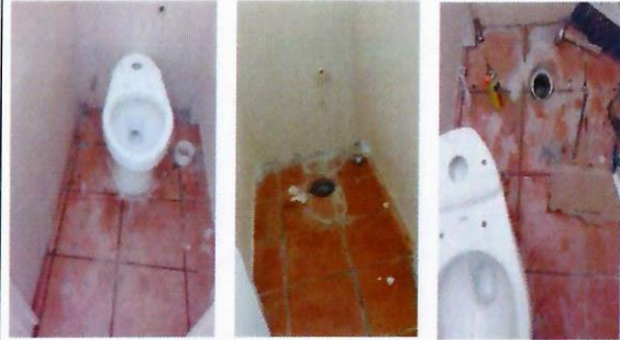
F13: Proceso de cambio e instalación de muebles sanitarios, W.C.
