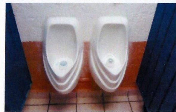
F27: Suministro y colocación de mingitorio seco
