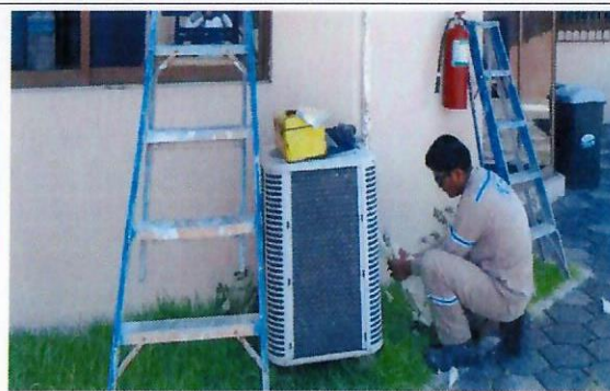
F22: Revisión y limpieza General Aire Acondicionado
