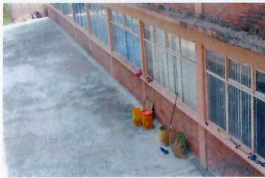
F13: Trabajos de fabricación de sello en junta constructiva y chaflán de cemento arena.
