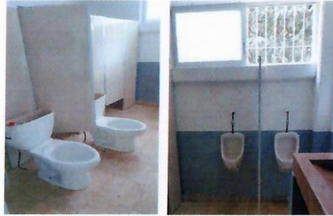
F36: Proceso de cambio de muebles sanitarios, (w.c. y mingitorios).
