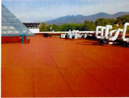
F8: Impermeabilización de techumbre
