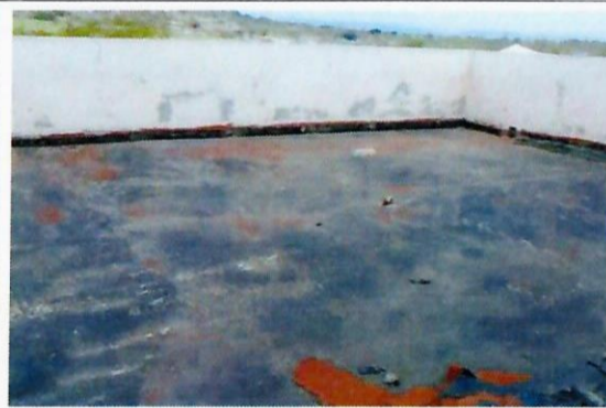
F25: Retiro de impermeabilizante prefabricado en el edificio 003 auditorio
