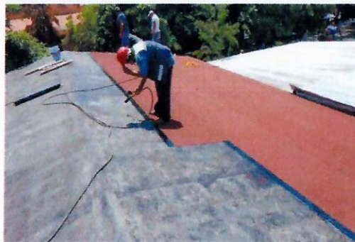
F16: Colocación de impermeabilización
