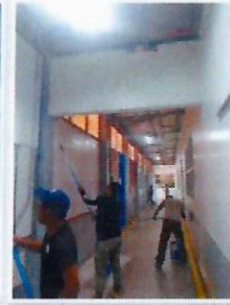
F17: TAMULBA: Aplicación de pintura vinílica y de esmalte en muros interiores de edificio
