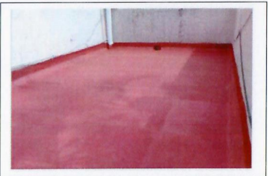
F18: Impermeabilización de acrílico en sanitarios del auditorio de la FDyCS, edif. 51
