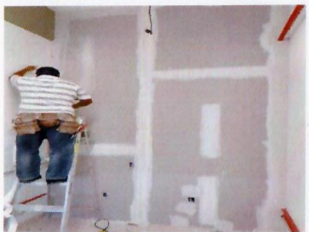
26: Proceso de instalación de muro de tabla roca
