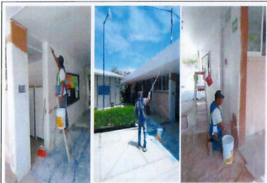
F30: Aplicación de pintura vinílica en muros, columnas, traves y plafones.
