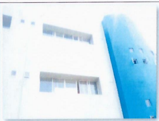
F27: Impermeabilización en muros a base de dos capas de impermeabilizante acrílico 7 años y una capa de membrana poliéster marca sika edificio 2
