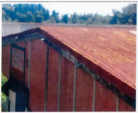
F9: Vista del Techo, impermeabilizante que se retirará LOU.
