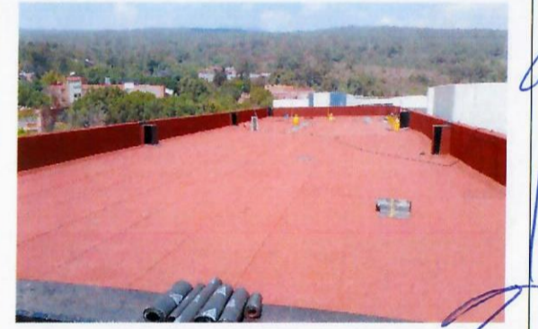
F13: Colocación de impermeabilizante prefabricado en losa.
