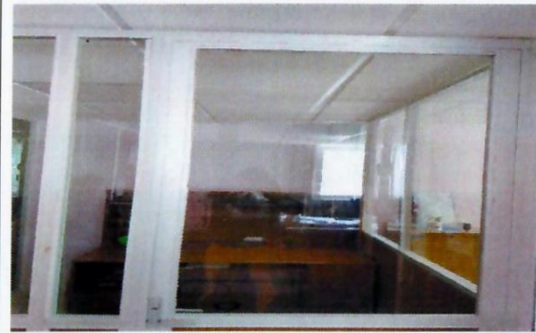
F14: Suministro y colocación de cancelería interior de Aluminio anodizado Natural.
