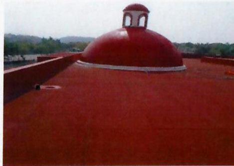
F27: Impermeabilización acrílica en azotea de segundo nivel del edificio
