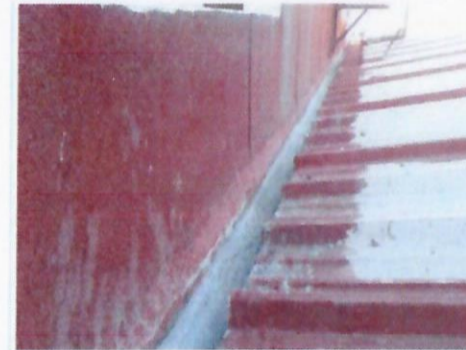
F13: Imagen de los trabajos de renovación y sellado de canal pluvial
