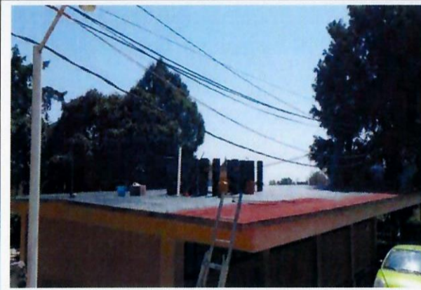
F4: Colocación de impermeabilizante prefabricado en losa de azotea.
