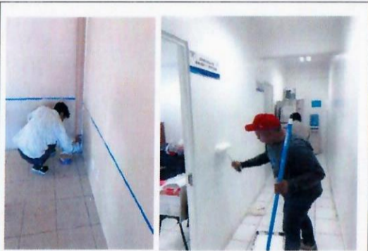
F17: Aplicación de pintura en muros.
