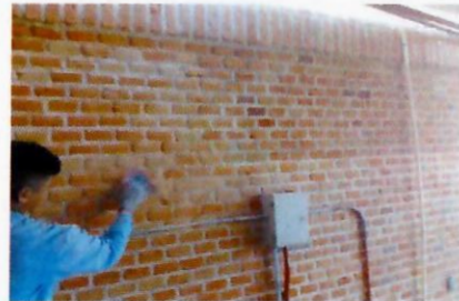
F19: Fachada principal (limpieza Limpieza de tabique aparte con lija y cepillo de alambre
