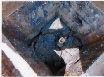
P38: Tierra física instalada
