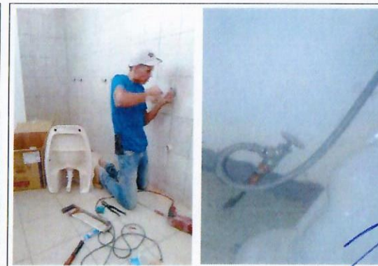
F23: Rehabilitación de salidas hidrosanitarias
