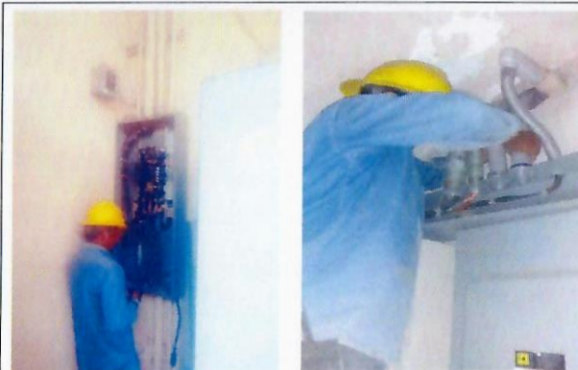
F12: Verificación por parte del contratista la variación de voltaje.
