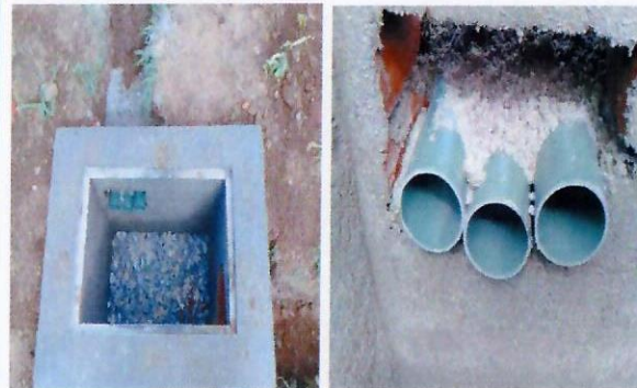
F24: Tubería para instalación eléctrica del laboratorio
