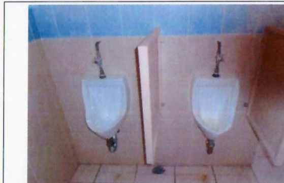
F2: Cambio de mingitorio por mingitorios secos EDIFICIOS 65 Y 66
