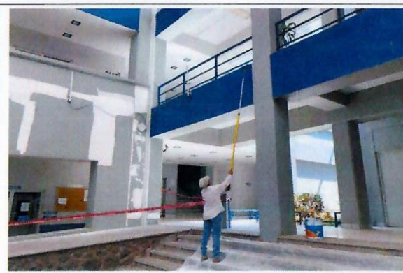
F21: Proceso de resane de grietas y aplicación de pintura. . En interiores.
