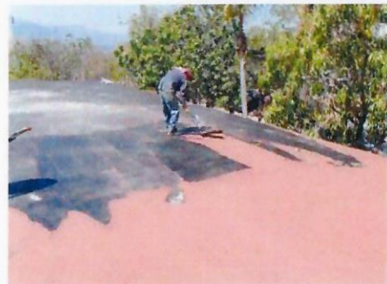
F11: Retiro de impermeabilizante prefabricado en edificio 2
