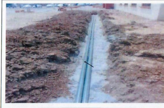
F8: Alimentador eléctrico de las dos cisternas
