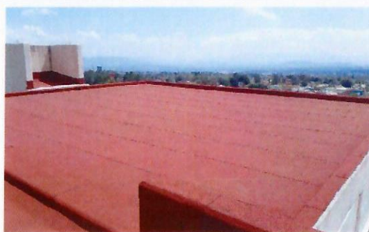
F18: Trabajos terminados de colocación de impermeabilizante prefabricado en cubo de escaleras, al fondo ducto de elevador.
