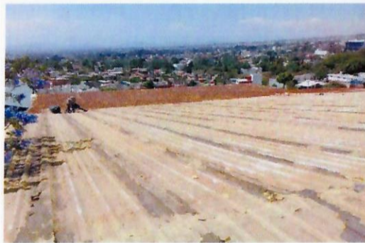
F10: Vista de cubiertas con áreas en proceso de retiro de impermeabilizante deteriorado, previa a los trabajos de colocación de nuevo impermeabilizante
