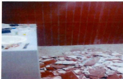
F7: Sanitarios: demolición de azulejo
