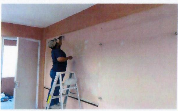
F10: Suministro y aplicación de pintura vinilica acrílica lavable vinimex
