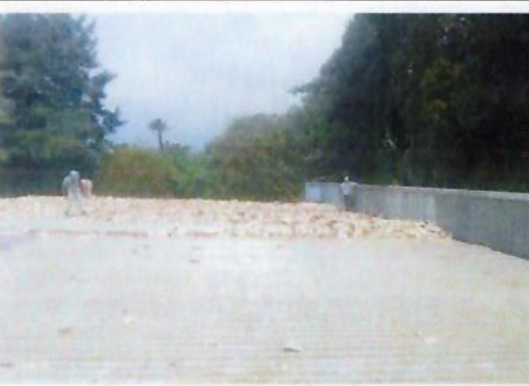
F19: Imagen de los trabajos de limpieza de residuos de impermeabilizante deteriorado de poliuretano existente en cubierta metálica, lado poniente de LOU.
