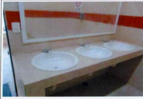
F16: Edificio 32, colocación de lavabos y llaves economizadoras.
