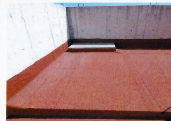
F5: Corte de lamina, no tiene tapa de costilla.
