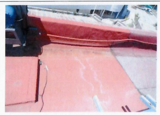
F-4: Retiro, suministro y aplicación de impermeabilizante
