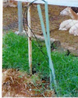
F16: Suministro, colocación y conexión de cable de cobre con aislamiento ( NEGRO O BLANCO) THW, CAL. #8
