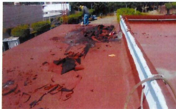
F24: Retiro de impermeabilizante
