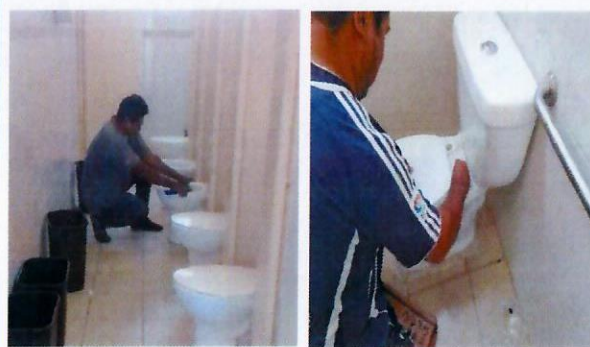
F12: Retiro y colocación de muebles sanitarios
