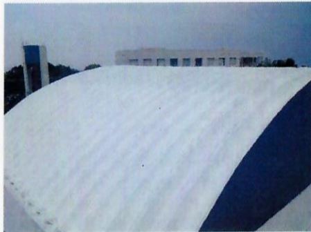
F11: Techo Edificio 49, impermeabilización con pintura elastométrica en arco techo
