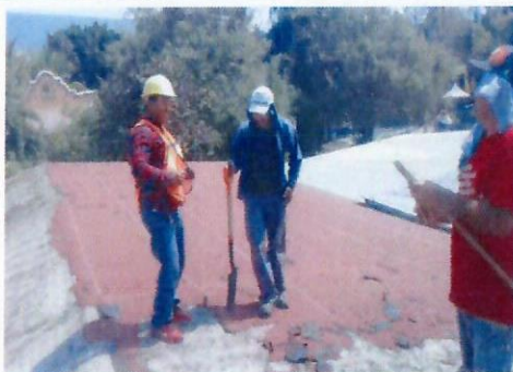
F15: Retiro de impermeabilizante existente
