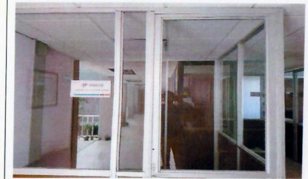
F15: Suministro y colocación de cancelería interior de Aluminio anodizado Natural.
