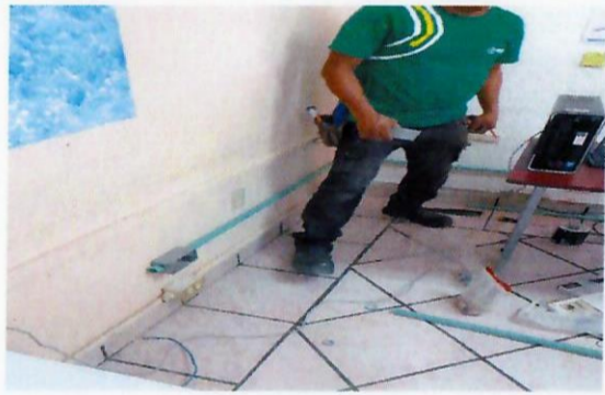
F18: Normalización de instalación eléctrica en centro de computo
