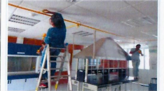
F31: Aplicación de pintura de esmalte en tubería de cobre, para distinguir la conducción de gas LP en laboratorio. (LOU)
