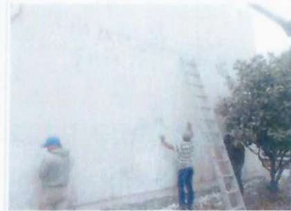
F15: TAMULBA: Limpieza de capas de pintura en mal estado sobre muros de fachada principal
