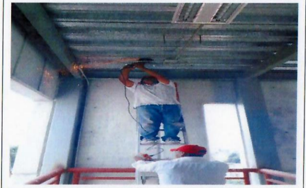
F10: Proceso de corte para costilla de losa, no había acceso a losa.
