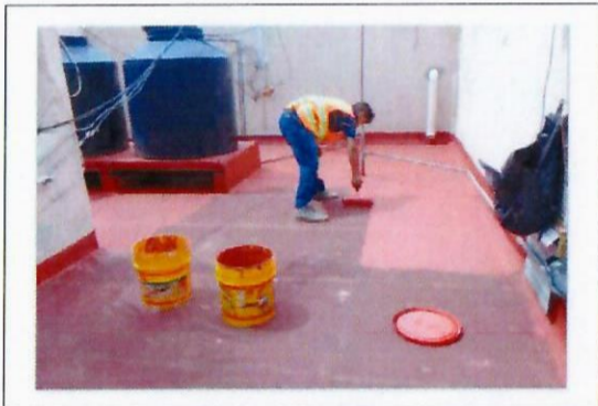
F14: Trabajos de impermeabilización en sanitarios del auditorio de la FDyCS, edif. 51
