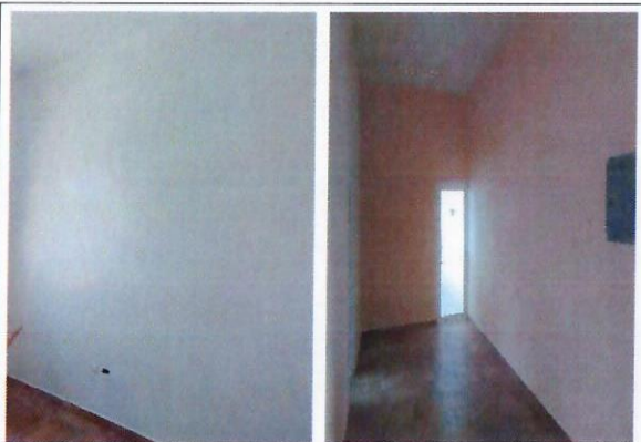
F31: Muro detallado y pintado de tablaroca
