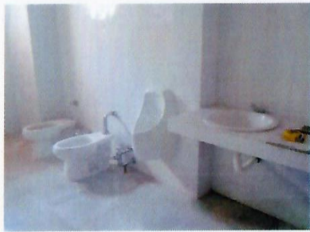
F34: Azulejo, piso, sanitarios con fluxómetro de pedal, mingitorio ecológico y barra con obalines, todo nuevo (hombres)
