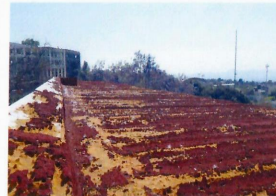
F8: Retiro de impermeabilizante
