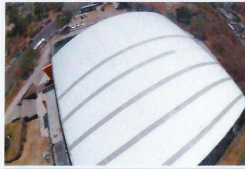
F4: Vista general de la cubierta metálica de arcocheo donde se aprecian las franjas oscuras de láminas traslúcidas.
