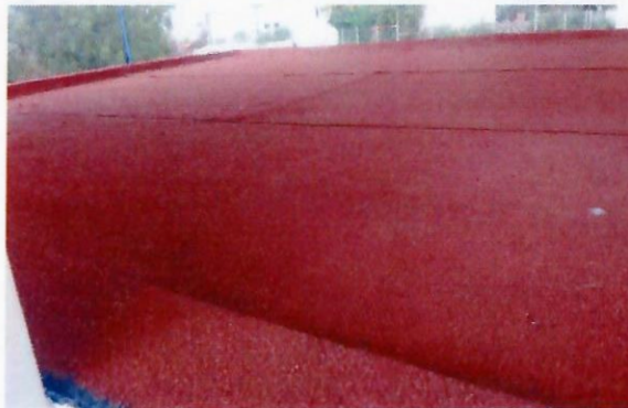
F19: Losa con impermeabilizante prefabricado.
