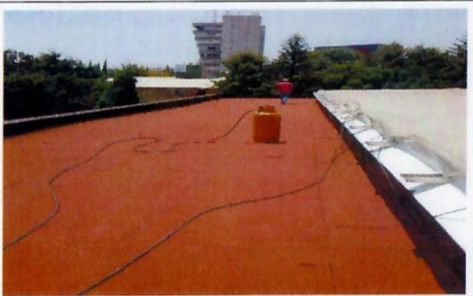
F13: Terminando impermeabilización en edificio de llegada (norte)
