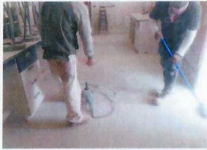
F25: Imagen de retiro de residuos previo a los trabajos de aplicación de pintura epóxica en piso de laboratorio, primer nivel lado sur de edificio 35 FCQel.
