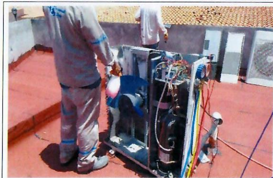
F23: Revisión y limpieza General Aire Acondicionado
