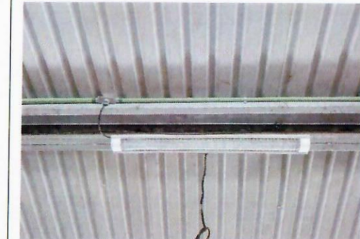
F17: Suministro y tendido tubo conduit PVC pesado 19 MM. DIÁMETRO, TRAMO DE 3.00 M.
