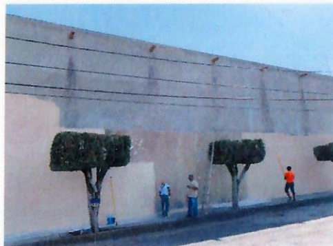
F9: Suministro y aplicación de pintura vinílica acrílica lavable vinimex aplicada en muros
