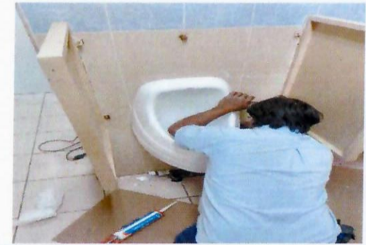
F8: Suministro y colocación de muebles sanitarios.
