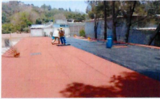
F15: Vista general de los trabajos de colocación de impermeabilizante prefabricado
