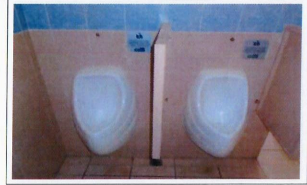
F11. EDIFICIOS 65 Y 66 Colocación de mingitorios secos.
