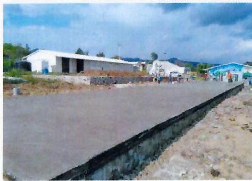
F26: Firme de concreto 10 cm de espesor reforzado con malla electrosoldada, para 5 aulas
