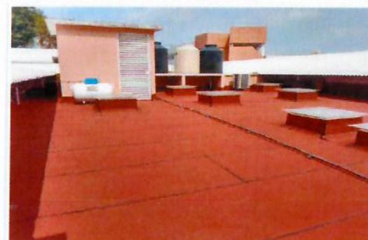
F15: Colocacion de membrana de impermeabilizante prefabricado en losa de acceso oeste. TAMULBA
