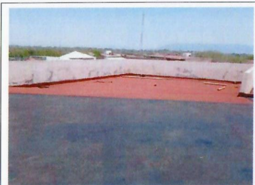
F36: Retiro de impermeabilizante prefabricado en el edificio 001 Dirección y Área administrativa
