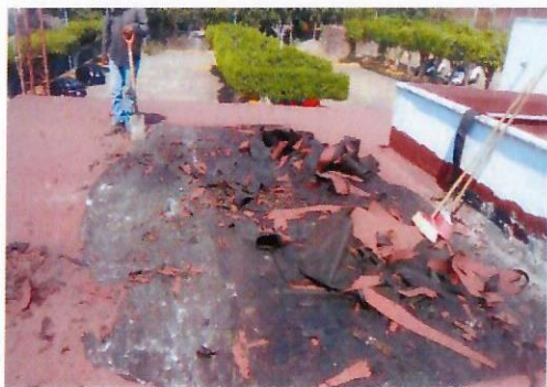
F23: Retiro de impermeabilizante
