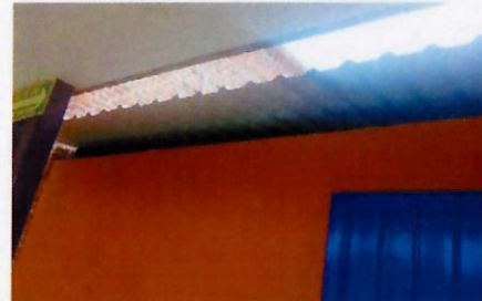
F30. Techumbre de lámina galvanizada pre pintada a fuego
