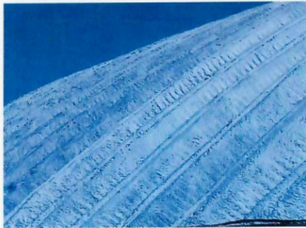
F7: Archotecho en proceso con primer aplicado del Edificio 49
