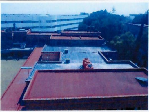
F9: Superficie preparada para recibir impermeabilizante.
