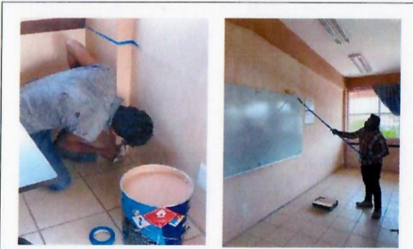
F18: Aplicación de pintura en muros.
