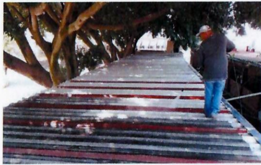
F9: Se realizaron trabajos de limpieza y preparación de la superficie previa a la colocación de impermeabilizante
