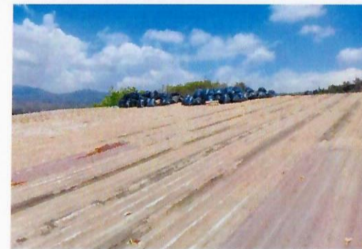
F11: Libre de impermeabilizante deteriorado existente
