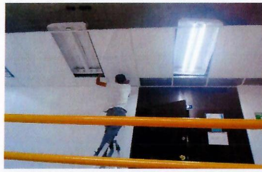
F19: Desmontar lámparas de gabinete, suministro y colocación de galletas de falso plafón
