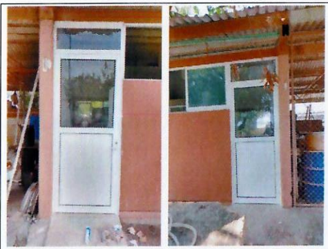
F33: Colocación de puertas de aluminio
