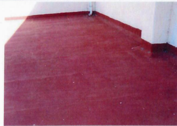
F2: Impermeabilización en losas de concreto
