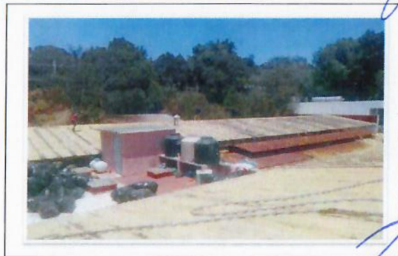
F12: Techo TAMULBA: Vista general de los trabajos de limpieza previas a la aplicación de impermeabilizante espeso.
