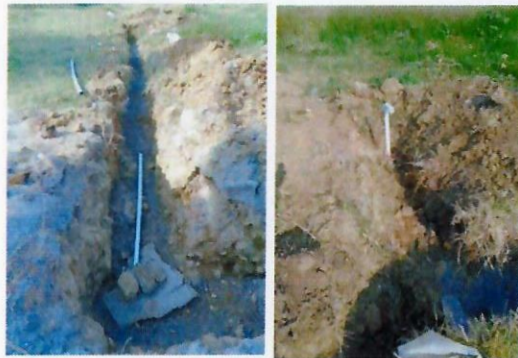
F9: Colocación de tubo pvc hidráulico para agua del sistema de riego.
