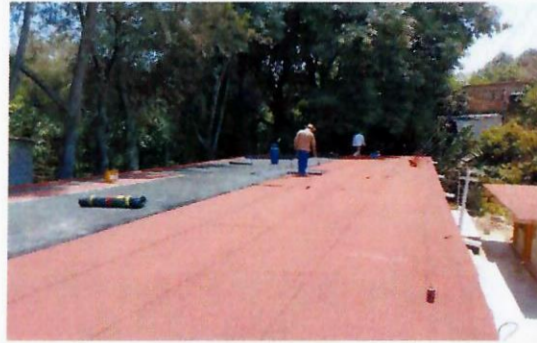
F16: Vista general de los trabajos de colocación de impermeabilizante prefabricado
