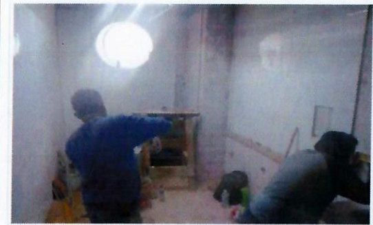
F14: Sanitarios: Colocación de azulejo en proceso.
