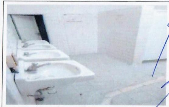
F5: Lavabos en mal estado edificio B se desmontarán
