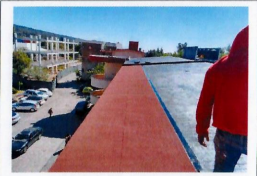
F9: Proceso de aplicación de impermeabilizante.
