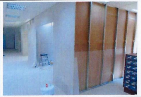
F6: Colocación de placas de muro divisorio.
