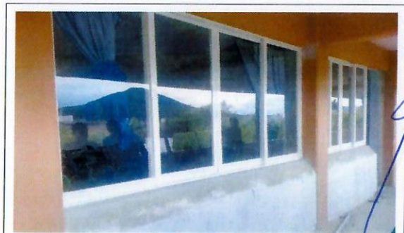
F41: Suministro y colocación de cancelería de aluminio blanco en salones de planta alta en Edificio C.
