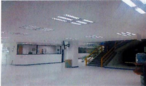
F38: Falso Plafon colocado
