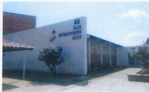
F42: TAMULBA-FCQel: Trabajos terminados de aplicación de pintura vinílica en muros de fachada principal así como de pintura de esmalte en estructura y puertas metálicas.
