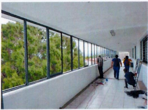
F5: Colocación de cancelería de aluminio Duranodick
