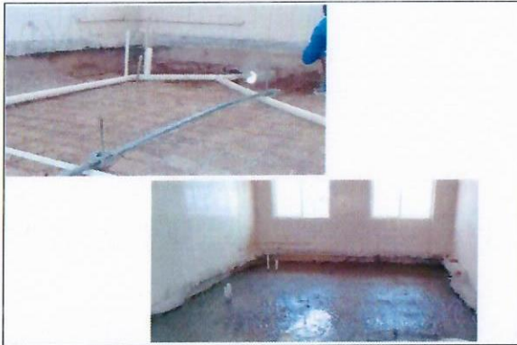
F22: Instalación de tubería de PVC DE 2" para mesas de laboratorio.
