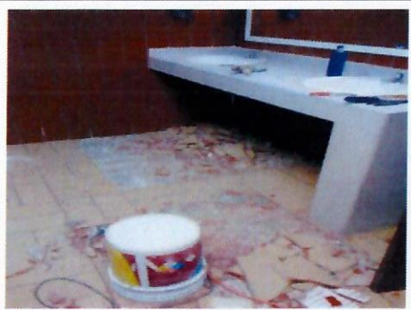
F6: Sanitarios: demolición de piso
