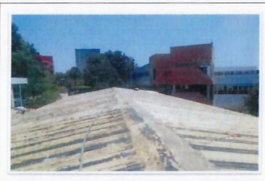
F11: Techo TAMULBA: Retiro de material deteriorado sobre laminas metálicas y cumbre de cubierta, lado sur de edificio
