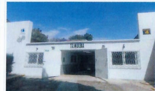
F43: TAMULBA-FCQel: Trabajos terminados de aplicación de pintura vinílica en muro y pintura de esmalte en puertas y protecciones de ventanas.
