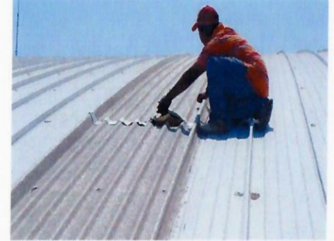
F11: Imagen de los trabajos iniciales de retiro de sello en traslapes de láminas traslucidas y metálicas de arcotecho.
