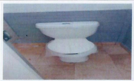
F90: Colocación de excusados ahorradores en área de módulo sanitario de edificio (TAMULBA)
