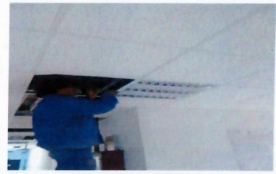
F20: Techo: colocación de lámpara led
