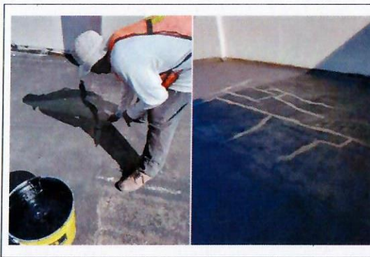
F15: Techo del edificio: Vista de los trabajos de calafateo en grietas de losa
