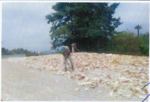
F20: Imagen de los trabajos de limpieza de láminas traslucidas existentes en cubierta metálica de LOU.
