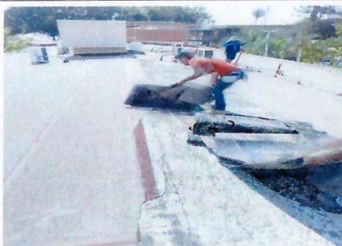
F18: Retiro de impermeabilizante en E.E.S. Xalostoc
