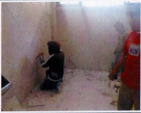
F17: Sanitarios: demolición de azulejo.
