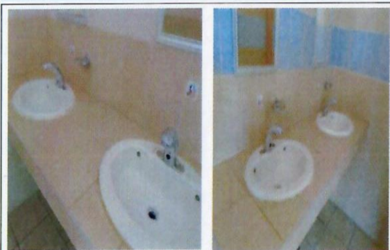
F1: Cambio de llaves de lavabo manuales por electrónicas. EDIFICIOS 65 Y 66
