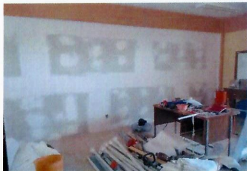
F14: Colocación de muro de tablaroca
