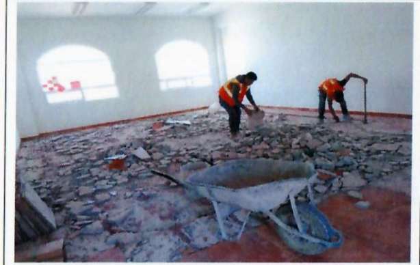
F26: Demolición de loseta.
