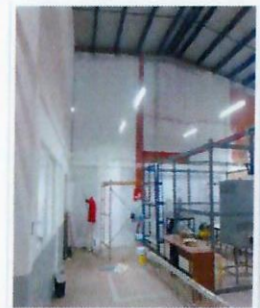
F20: LOU: Trabajos de aplicación de pintura vinílica en muros perimetrales al interior de la nave principal.
