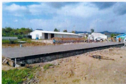
F27: Firme de concreto 10 cm de espesor reforzado con malla electrosoldada, para 5 aulas
