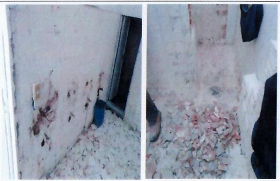
F13: Demolición de loseta de cerámica en pisos y muros en el módulo de baños de edificio B
