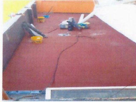
F10: Trabajos de colocación de impermeabilizante en azotea de acceso a Polideportivo 1.
