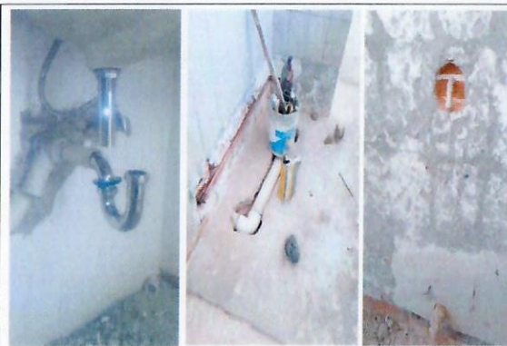
F22: Rehabilitación de salidas hidrosanitarias
