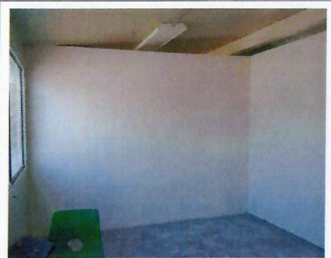
F36: Trabajo terminado de la colocación del muro de tablaroca en aula de usos múltiples.
