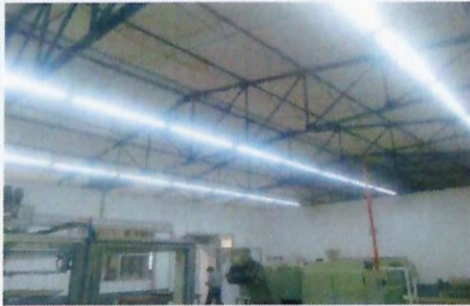
F48: Vista general de los trabajos concluidos de colocación de luminarias ahorradoras de energía tipo LED y su puesta en marcha. Laboratorios de TAMULBA
