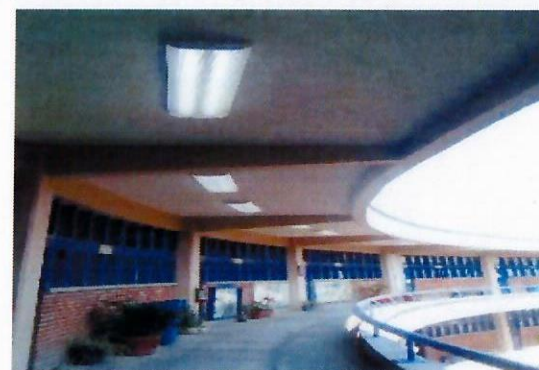
F16: Suministro y colocación de luminarias de sobreponeren pasillos.
