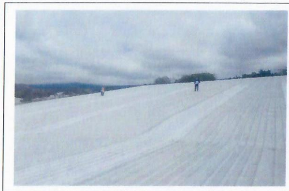
F16: Impermeabilización Edificio 20- GIMNASIO AUDITORIO.
