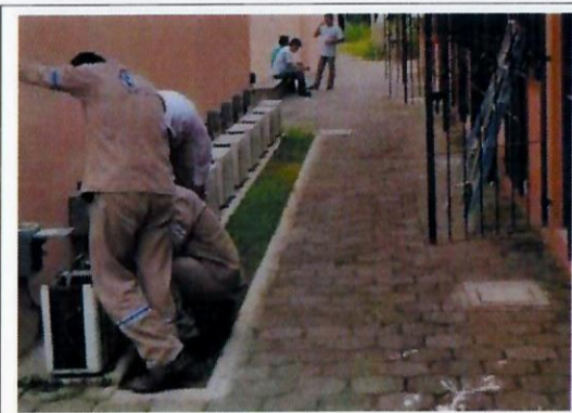
F39: Revisión y limpieza General . Aire Acondicionado
