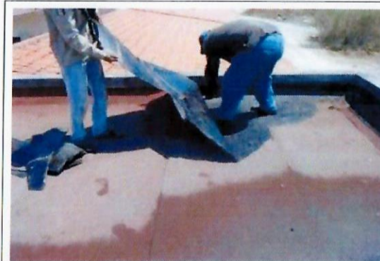
F26: Retiro de impermeabilizante prefabricado en el edificio 011 cuarto de máquinas y bodega.
