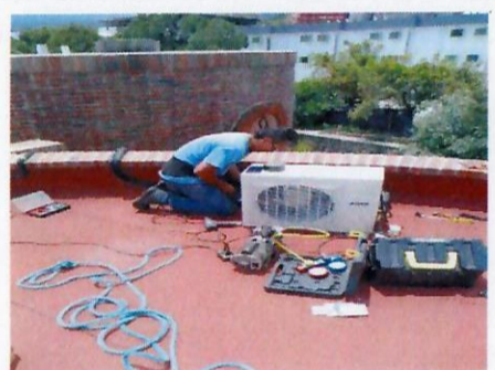
F29: Proceso de instalación de nuevos mini split
