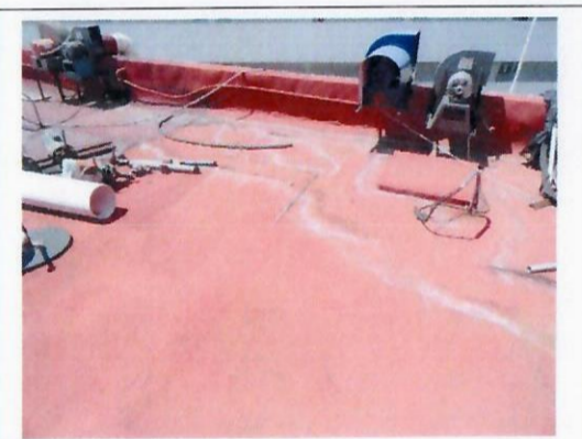
F-3: Retiro, suministro y aplicación de impermeabilizante
