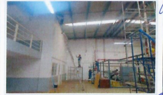
F34: Trabajos de aplicación de pintura vinílica en muros y esmalte en estructuras metálicas interiores. (LOU)
