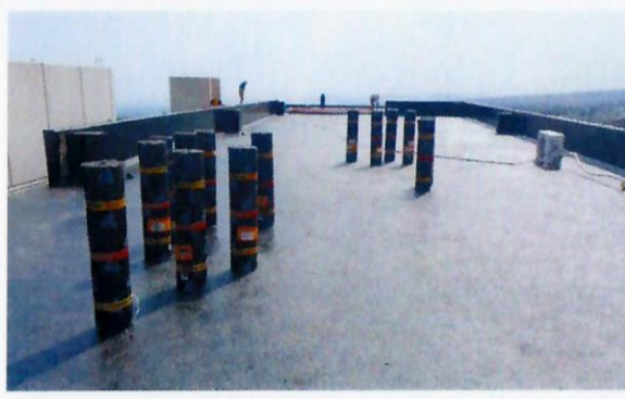
F12: Aplicación de Primer para colocar carpeta asfáltica.
