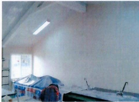
F18: Aplicación de pintura en muros de tablaroca
