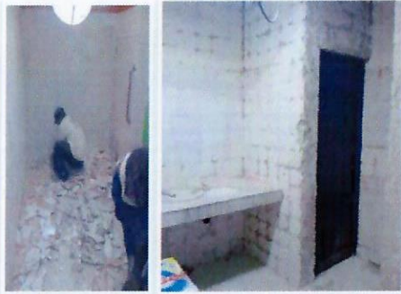
F12: Sanitarios: demolición de azulejo y piso.
