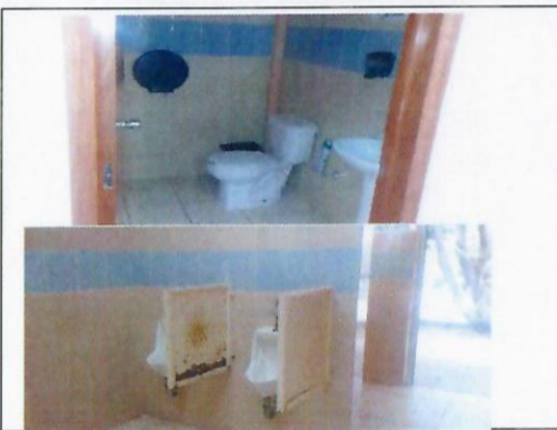
F12: Colocación de muebles sanitarios.
