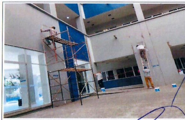
F22: Proceso de resane de grietas y aplicación de pintura. . En interiores.
