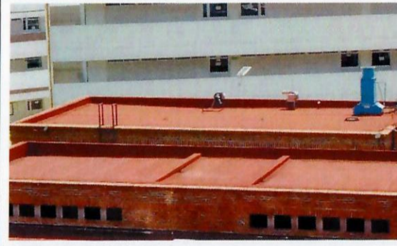
F11: Impermeabilizante terminado
