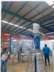
F21: LOU: Trabajos de aplicación de pintura de esmalte en tuberías interiores de instalaciones en diámetros varios.
