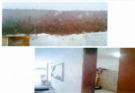
F25: Retiro de emboquillado de puertas y ventanas y aplanado de muros acabado repellado en el módulo de baños de edificio B
