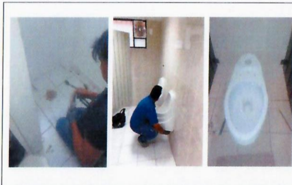
F15: Proceso de instalación de sanitarios y mingitorios.
