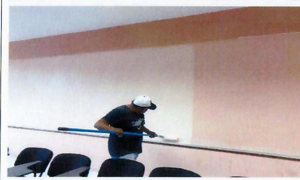
F11: Suministro y aplicación de pintura vinilica acrílica lavable vinimex
