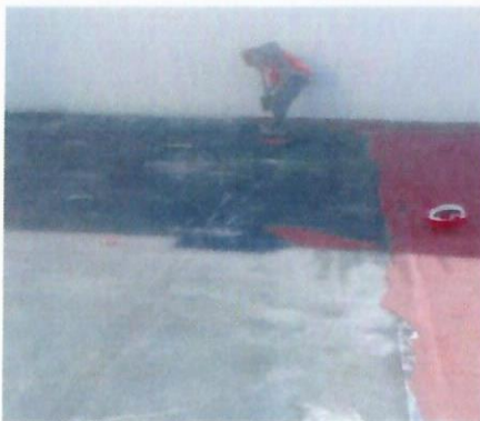
F11: Retiro de impermeabilizante prefabricado
