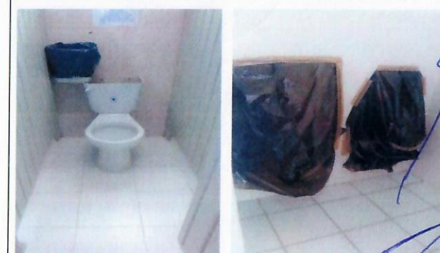
F5: Desmontaje, suministro y colocación wc, mingitorio.
