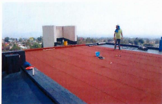
F14: Proceso de impermeabilización en losa.
