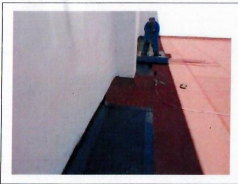
F14: Techo del edificio: suministro y colocación de impermeabilizante prefabricado
