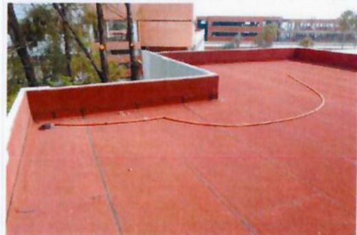
F28: Vista general de los trabajos terminados de impermeabilización prefabricado en losa de anexo TAMULBA.
