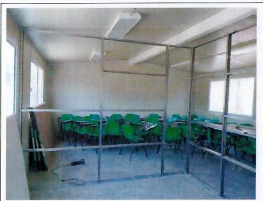
F21: Colocación de estructura metálica para muro de tablaroca en aula de usos múltiples
