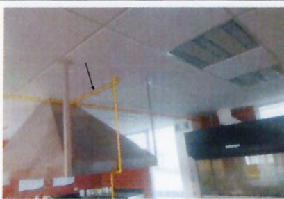
F89: FCQel-LOU: Salida de Gas con tubo de cobre.
