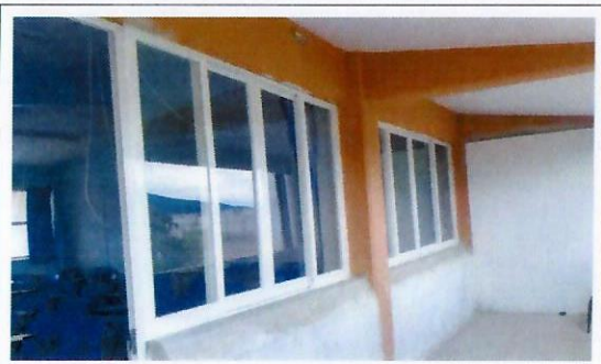
F40: Suministro y colocación de cancelería de aluminio blanco en salones de planta alta en edificio C.
