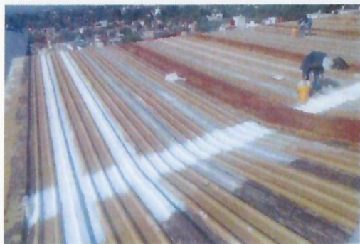
F12: Trabajos de calafateo en traslape de láminas de multipanel, lado sur de edificio
