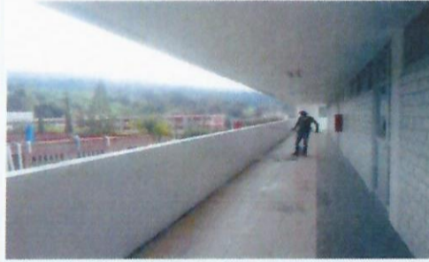
F27: Aplicación de pintura vinílica en pretils y muros de pasillos principales, área exterior noroeste segundo nivel, edificio 35 FCQel.
