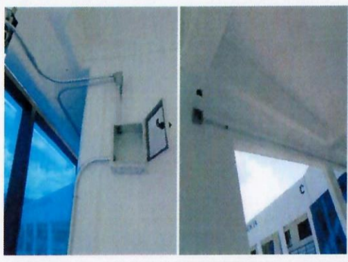
F17: Colocación de tubería de voz datos
