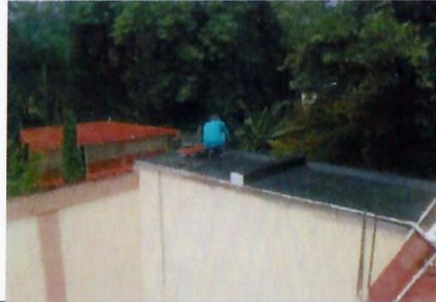
F10: Colocación de impermeabilizante
