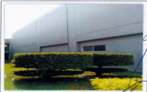
F29: Impermeabilización en muros a base de dos capas de impermeabilizante acrílico 7 años y una capa de membrana poliéster marca sika edificio 1
