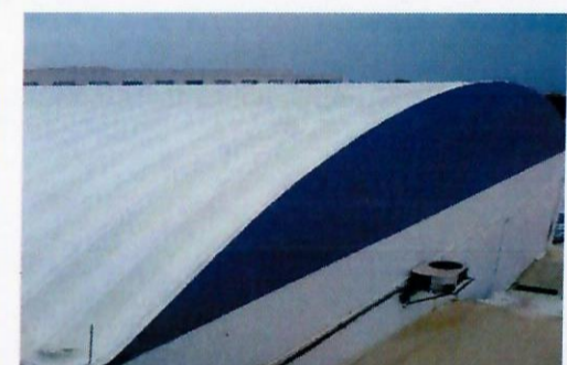
F10: Techo Edificio 49, impermeabilización con pintura elastométrica en arco techo
