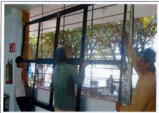
F20.Desmontaje de puertas y ventanas metálicas y/o madera en aulas de investigación y tutorías en edificio 3
