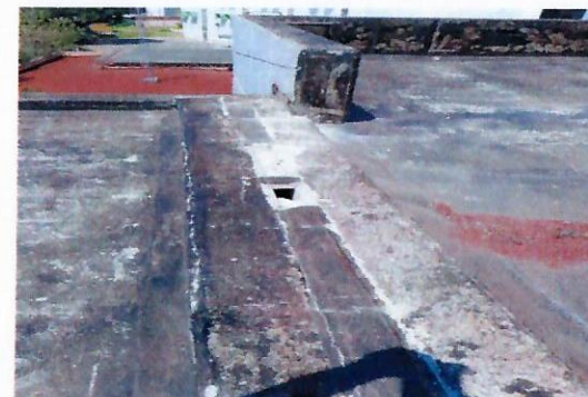
F16: Retiro de impermeabilizante.
