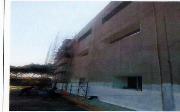
F19: Impermeabilización en muros a base de dos capas de Impermeabilizante acrílico 7 años y una capa de membrana poliéster marca sika edificio 2
