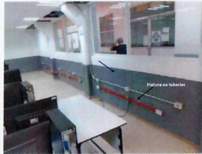
F44: TAMULBA-FCQel: trabajos de aplicación de pintura de esmalte en parte baja de muros así como en tuberías de instalaciones con diámetros variados.
