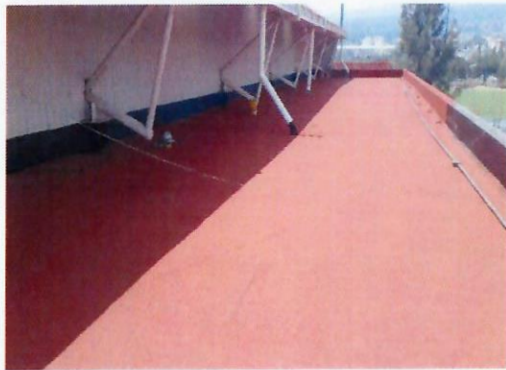
F18: Trabajos concluidos de impermeabilizante en área de gimnasio Polideportivo 1.
