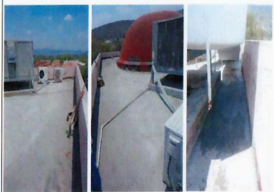
F33: Limpieza de área para impermeabilizar, edificio 003 auditorio
