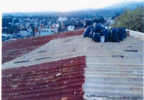
F9: Retiro de impermeabilizante de poliuretano existente en cubierta metálica de edificio
