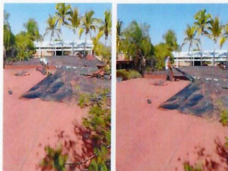
F8: Trabajos de retiro de impermeabilizante prefabricado en edificio 4.
