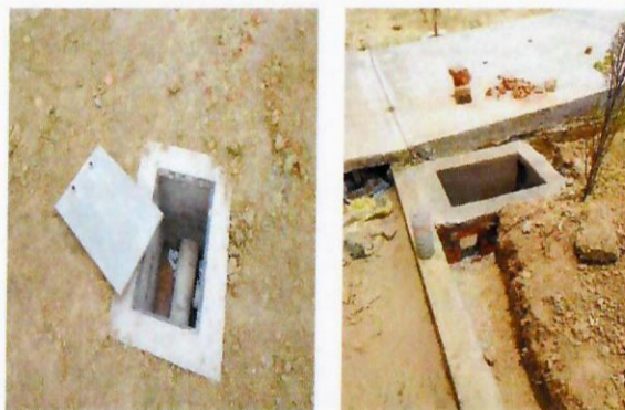
F14: Registro para la descarga del sanitario y registro para el agua potable del laboratorio.
