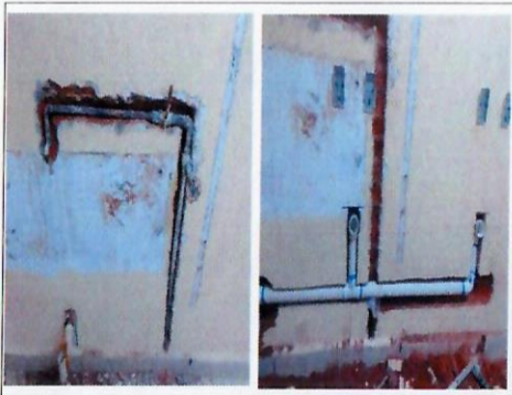
F23: Proceso de instalación hidrosanitaria.
