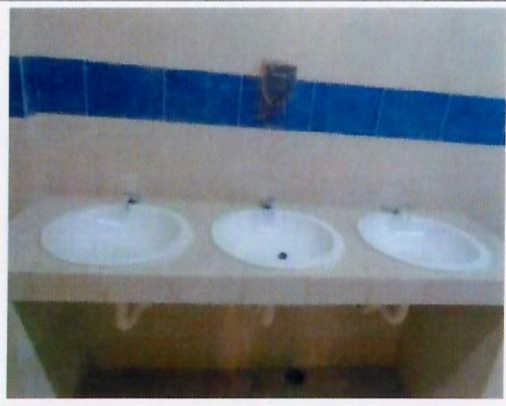
F15: Edificio 32, colocación de lavabos y llaves economizadoras.
