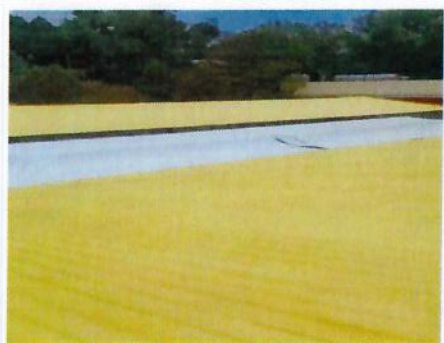
F13: Techo TAMULBA: Aplicación de mediante esparcido de espuma de poliuretano sobre cubierta metálica previa a recibir acabado final
