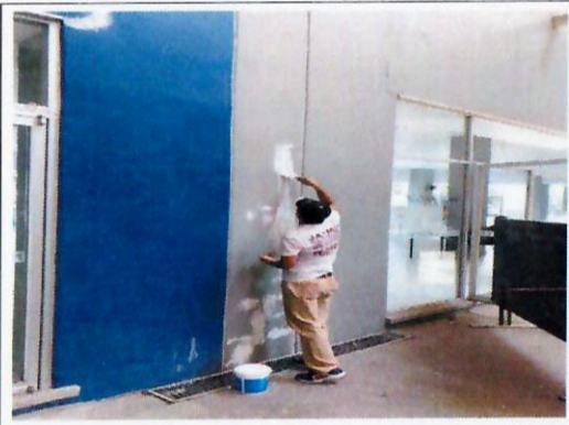
F23: Proceso de resane de grietas y aplicación de pintura. En interiores.
