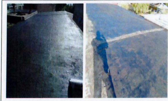
F10: Proceso de aplicación de impermeabilizante E.32
