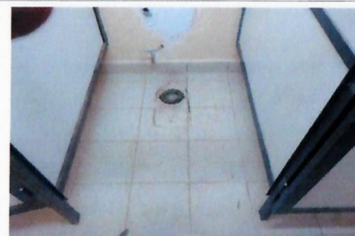
F34: Se desmontan muebles sanitarios
