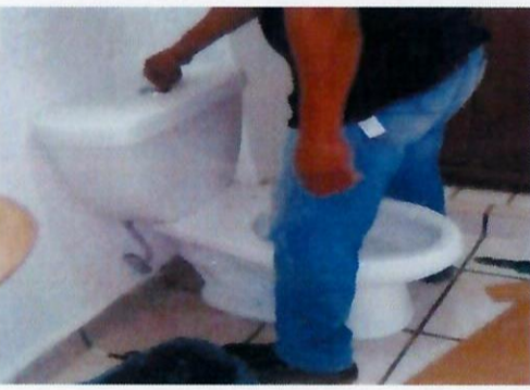
F20: Desmontaje y suministro de muebles sanitarios como lavabos, inodoro, mingitorio
