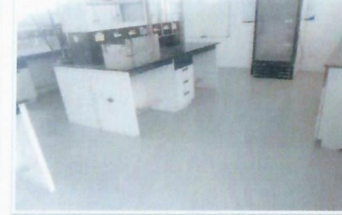
F85: Trabajos terminados de aplicación de pintura epóxica en piso de laboratorio primer nivel de edificio 35 FCQel.
