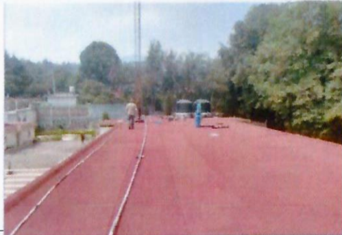
F9: Colocación de impermeabilizante
