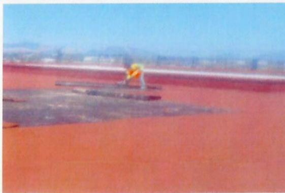
F18: Impermeabilización colocación de sistema prefabricado
