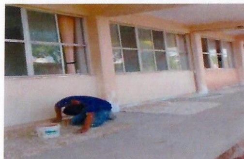
F18: Vista de los trabajos de suministro y aplicación de pintura vinílica acrílica edificio 4 y 3
