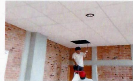
F20: Desmontaje del sistema de iluminación
