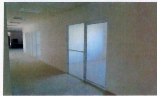
F17: Edificio 65, colocación de muro de tablaroca y cancelería de aluminio en planta baja.
