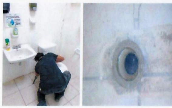
F21: Proceso de cambio de muebles sanitarios y instalación hidrosanitaria.
