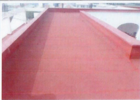
F28: Trabajo terminado de impermeabilización del edificio principal
