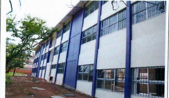
F24: Suministro y colocación de pintura en fachada, trabes, columnas y muros.
