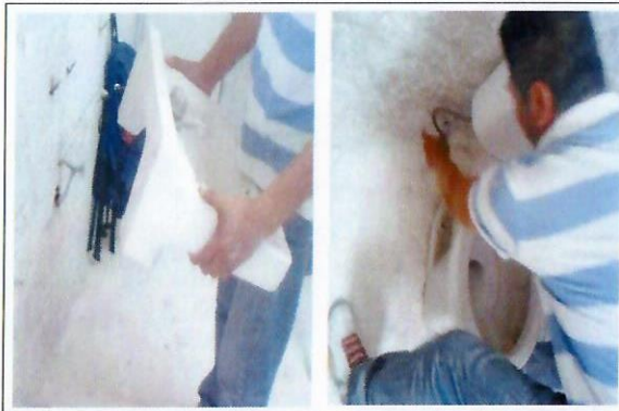
F16:Desmontaje de muebles sanitarios, lavabos, inodoros etc. en el módulo de baños de edificio B
