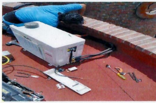
F30: Proceso de instalación de nueva mini split
