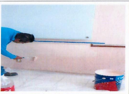
F12: Suministro y aplicación de pintura de esmalte alquídico
