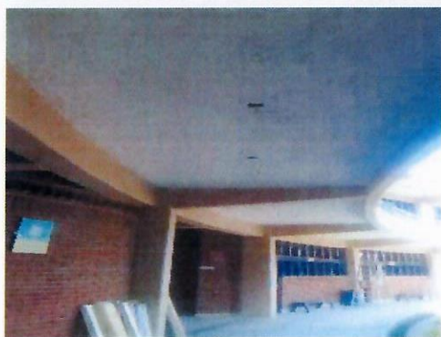
F12: Desmontaje de luminarias anteriores para colocar nuevas en pasillos
