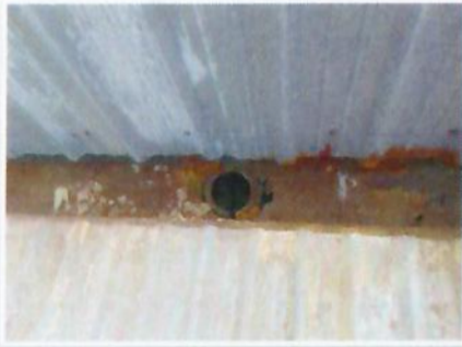
F21: Vista general de limpieza en canales metálicos adyacentes a cubierta metálica de LOU, previos a su reparación en áreas deterioradas.
