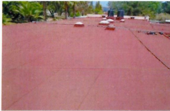
F21: Impermeabilización en losa de azotea
