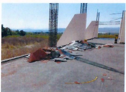
F12: Retiro de impermeabilizante prefabricado
