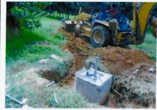
F11: Dados de concreto para punta de poste
