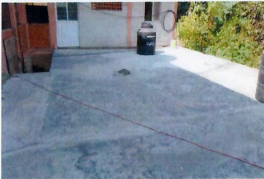
F12: Vista general de la losa de azotea con trabajos previos de limpieza para recibir sellado de fisuras.
