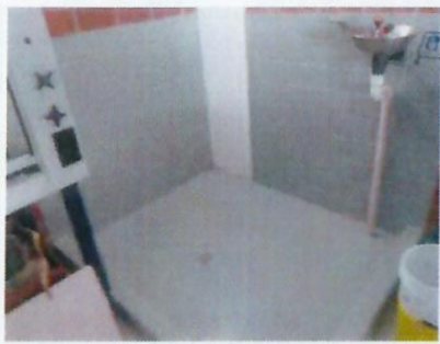
F86: Aplicación de pintura epóxica en muros y piso de área de lavajoy y regadera, laboratorio primer nivel, edificio 35 FCQel
