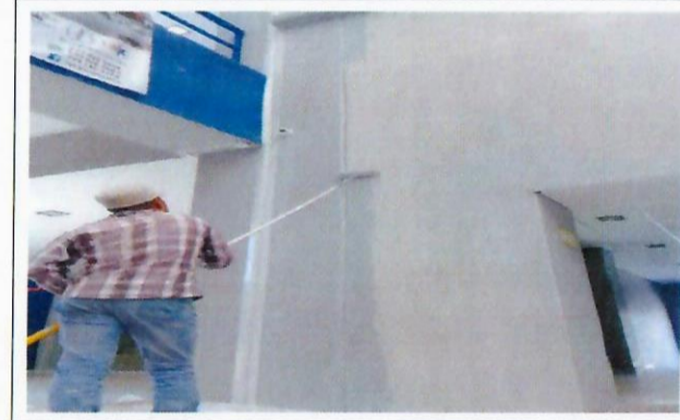
F25: Proceso de resane de grietas y aplicación de pintura. En interiores.
