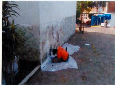
F17: Aplicación de pintura vinílica sobre muro de la fachada principal del edificio 5.
