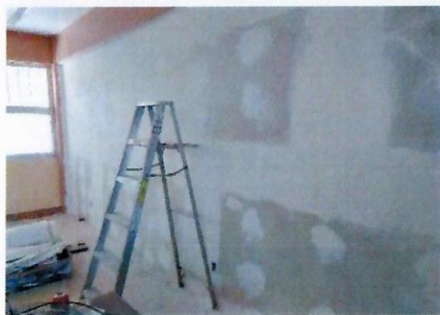
F11: Muros de tablaroca colocados.
