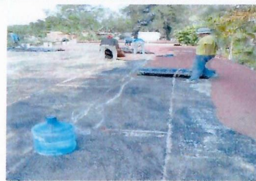
F19: Retiro de impermeabilizante en E.E.S. Xalostoc
