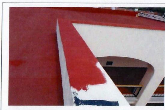
F19: Suministro y aplicación de impermeabilizante acrílico en azotea de segundo nivel del edificio
