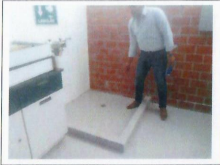
F6: Se aplicará Pintura epóxica en paredes de laboratorios (sardineles y piso de regaderas.) LOU.
