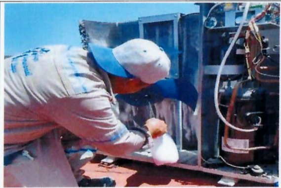
F40: Mantenimiento de aire acondicionado Edif. 1 Dirección
