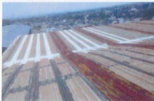
F13: Vista general de los trabajos de preparación para recibir impermeabilizante
