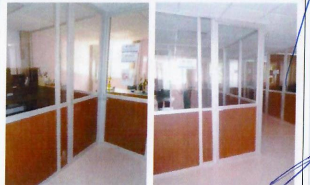
F12: Edificio 41, colocación de cancelería de aluminio en cubículos.
