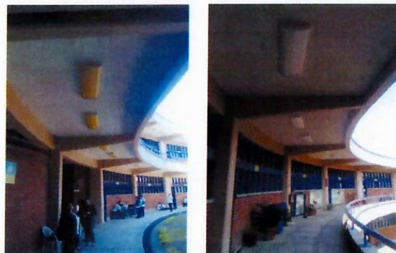
F7: Desmontaje y suministro y armado de luminarias de 30x1.22 en pasillos.
