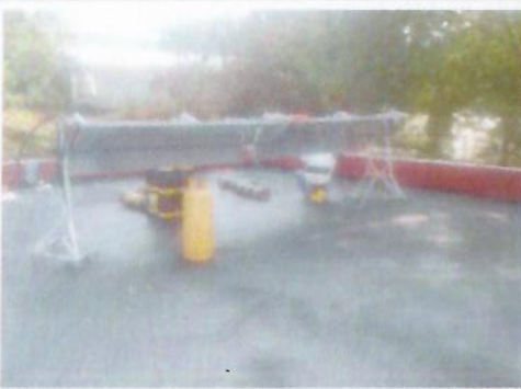
F17: Trabajos de retiro de impermeabilizante deteriorado y colocación de sellador primario en losa de anexo TAMULBA.
