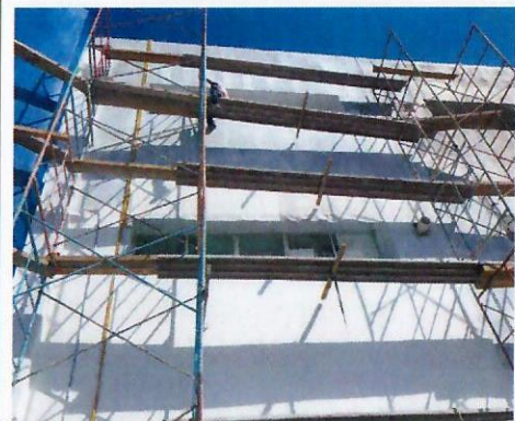
F17: Impermeabilización en muros a base de dos capas de Impermeabilizante acrílico 7 años y una capa de membrana poliéster marca sika edificio 5
