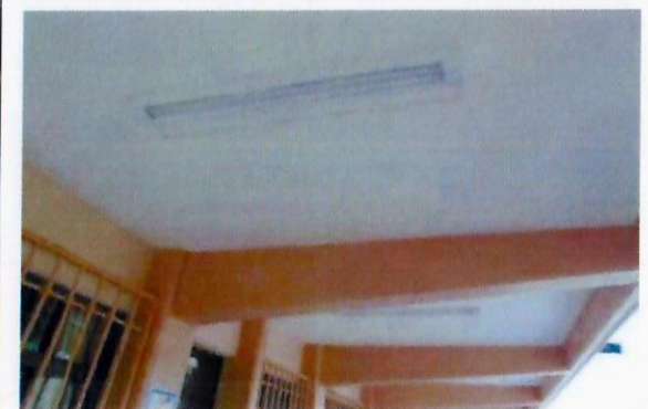
F19: Edificio 32, colocación de luminarias de led.
