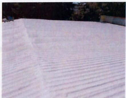
F39: Imagen de los trabajos terminados de aplicación de impermeabilizante de espuma de poliuretano con acabado final sobre cubierta metálica del edificio LOU
