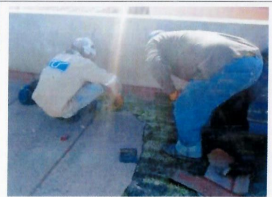
F31: Retiro de impermeabilizante prefabricado en el edificio 008
