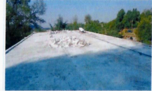
F11: Retiro de material de impermeabilizante existente.
