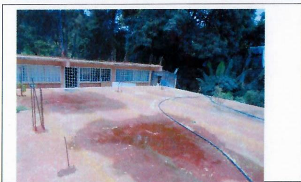
F3: Aplicación de Impermeabilización en azotea de Edificio Principal
