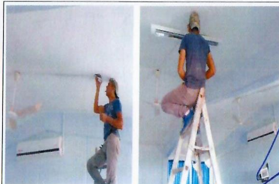
F32: Rehabilitación de salidas eléctricas, suministro y armado de conexión luminaria y apagadores.
