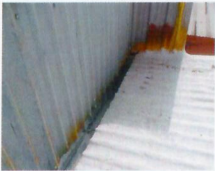
F24: Vista general de limpieza en canales metálicos adyacentes a cubierta metálica de LOU, previos a su reparación en áreas deterioradas.
