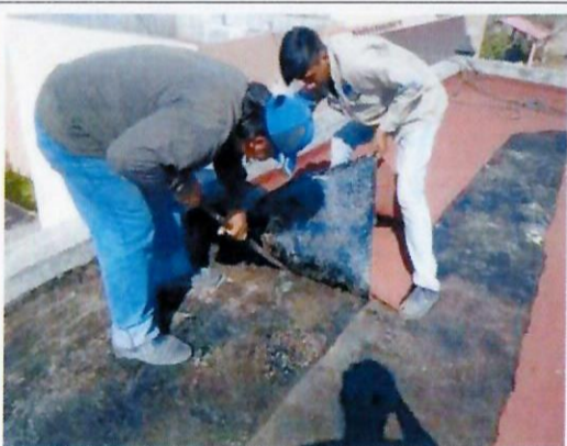
F30: Retiro de impermeabilizante prefabricado en el edificio 012 cubículos de investigación
