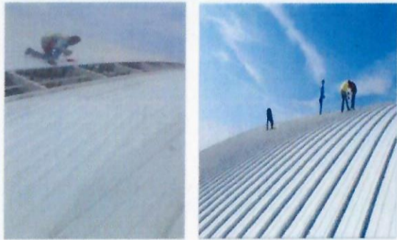
F12: Colocación de láminas traslucidas
