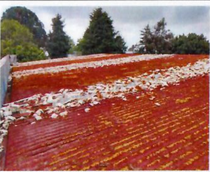
F18: Vista de los trabajos de retiro de impermeabilizante deteriorado de poliuretano en techumbre metálica de nave principal, lado norte de LOU.
