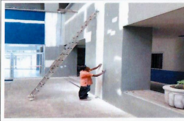
F24: Proceso de resane de grietas y aplicación de pintura. En interiores.
