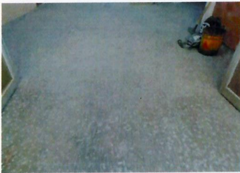
F13: Picado de piso para su posterior colocación de PISO, CIDU.
