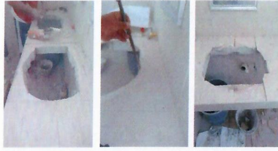
F14: Proceso de cambio e instalación de muebles sanitarios, lavabos.
