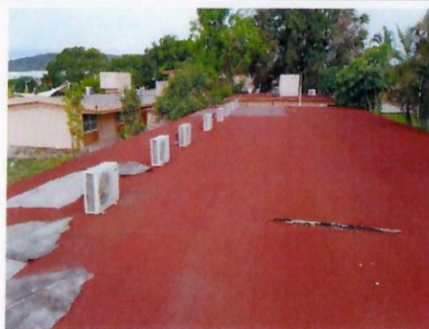
F2: Retiro y colocación de impermeabilización en el Laboratorio E-6 y E-7
