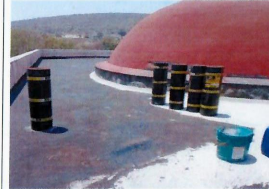
F35: Colocación de Primer para colocar Manto de impermeabilización, en el edificio 003 Auditorio.
