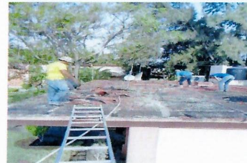
F17: Retiro de impermeabilizante
