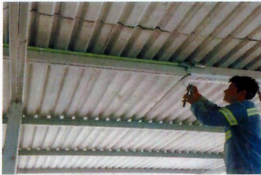
F15: Suministro y tendido tubo conduit PVC Pesado 19 MM. DIÁMETRO, TRAMO DE 3.00 M.
