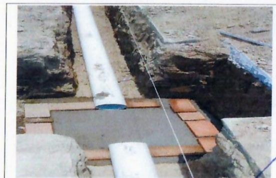
F22: Rehabilitación de un Dren Pluvial
