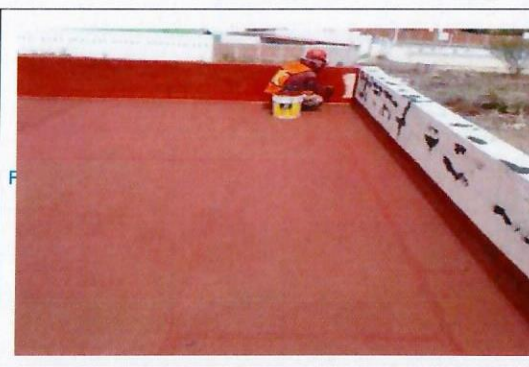
F18: Suministro y aplicación de impermeabilizante acrílico en azotea de segundo nivel del edificio
