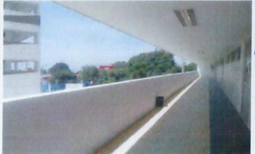
F52: Vista general de los trabajos terminados de aplicación de pintura vinílica en muretes de pasillos principales, área exterior sur de laboratorios edificio 35 FCQel.
