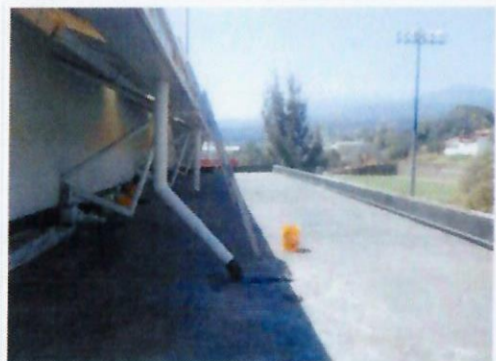
F1: Trabajos de retiro de impermeabilizante deteriorado en losa de azotea Polideportivo 1.
