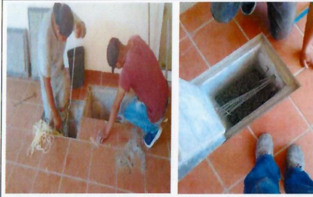
F25: Proceso de desazolve de registros eléctricos
