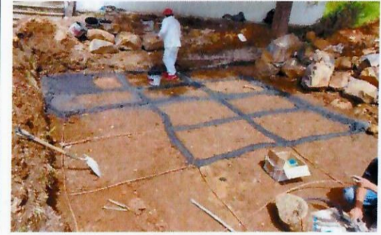
F25: Proceso de instalaciones de tierras físicas
