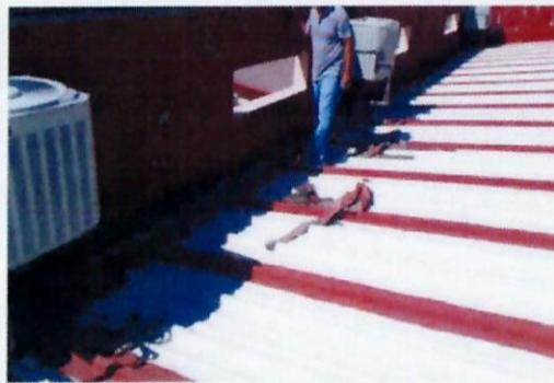
F12: Retiro de impermeabilizante deteriorado en canal pluvial adyacente a cubierta metálica
