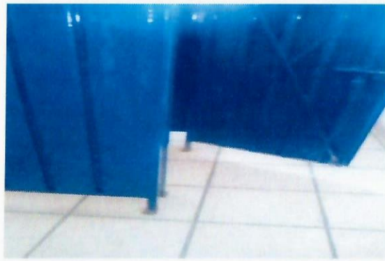
F15: Suministro y aplicación de pintura de esmalte alquídico en superficies metálicas
