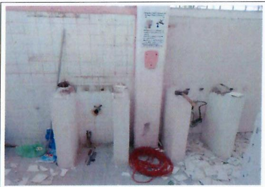
F15:Desmontaje de muebles sanitarios, lavabos, inodoros etc. en el módulo de baños de edificio B
