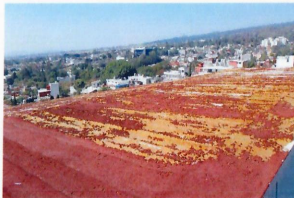
F7: Retiro de impermeabilizante
