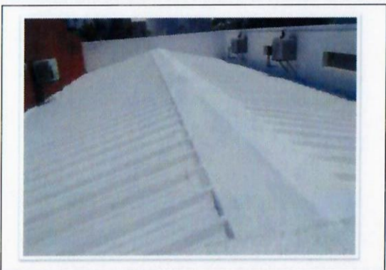
F15: Vista general de los trabajos de impermeabilización ya concluidos en cubierta de azotes del auditorio
