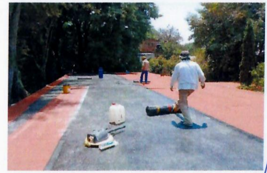
F14: Colocación de impermeabilizante prefabricado con membrana de 4 mm en superficies de losa de azotea.
