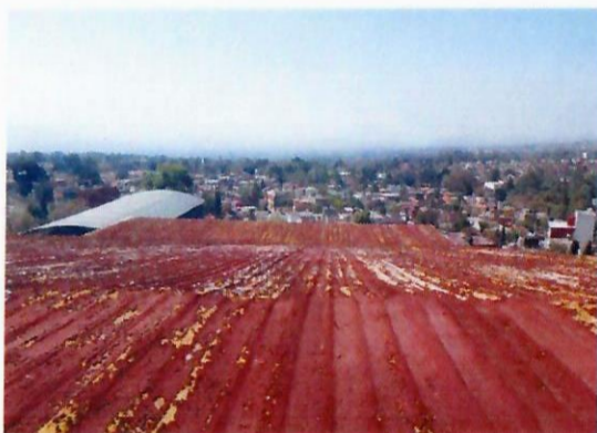
F6: Retiro de impermeabilizante
