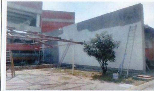
F18: TAMULBA: Aplicación de pintura en muros de fachada con preparación previa para recibir trabajos
