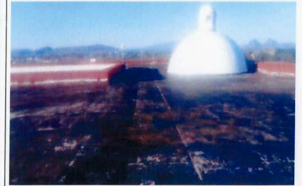
F20: Impermeabilización de azotea aplicación de primario
