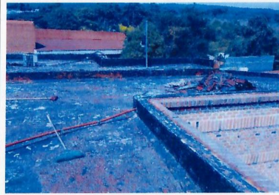
F7: Retiro de impermeabilizante anterior.
