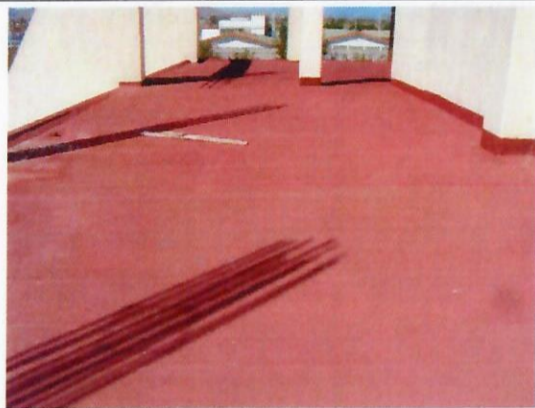
F1: Impermeabilización en losas de concreto
