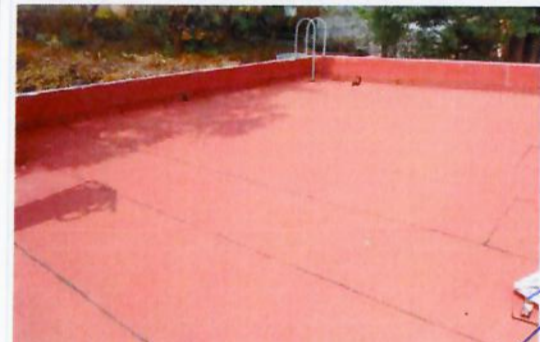
F29: Imagen de trabajos concluidos de impermeabilización con membrana prefabricado hacia fachada norte de anexo TAMULBA.
