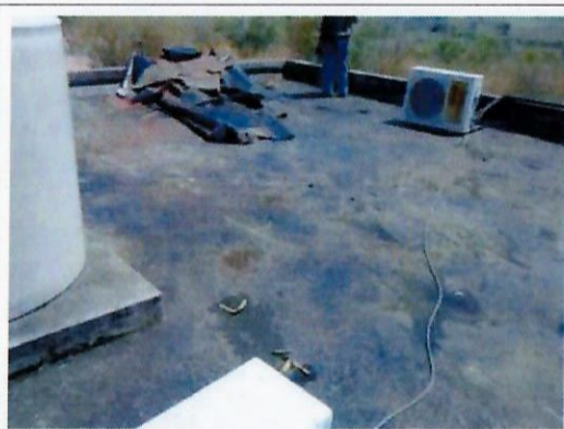
F27: Retiro de impermeabilizante prefabricado en el edificio 011 cuarto de máquinas y bodega.
