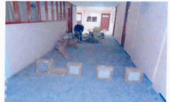
F15: Colocación de piso de loseta, CIDU.
