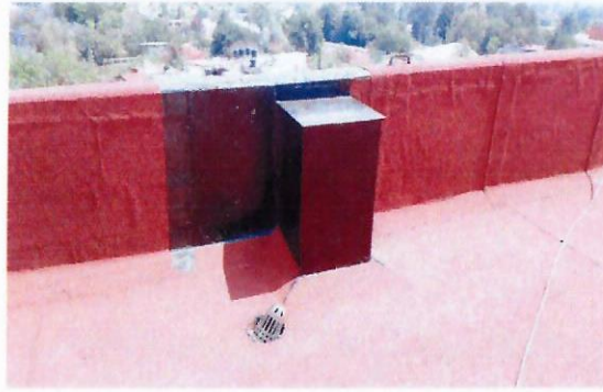
F15: Proceso de impermeabilización en losa.
